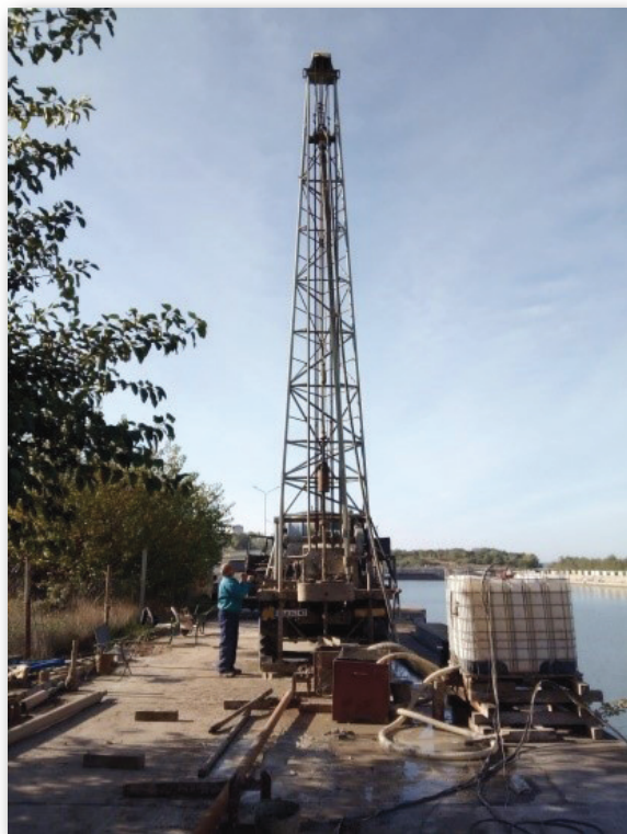
Автосонда УРБ2,5А по време на работа на кейовата стена на р. Дунав
