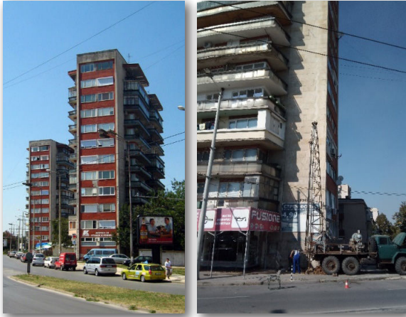
Инженерногеолошко проучване на земната основа на наклонения и слегнал настрани с 814 тт блок „Русия“ в гр. Русе
